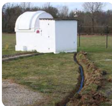
Mise en situation dans des gaines
